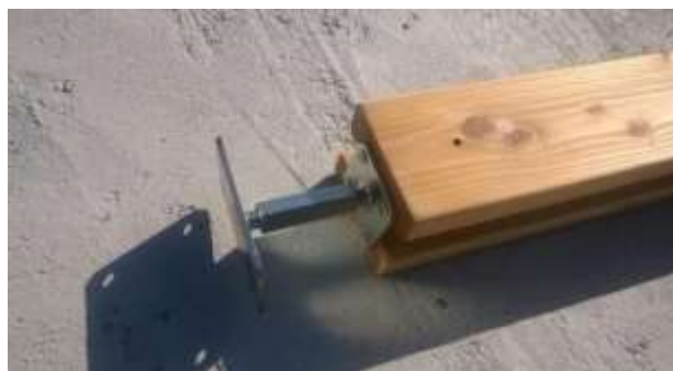
Fixations pied de poteau fixe avec 4 vis 8/80
