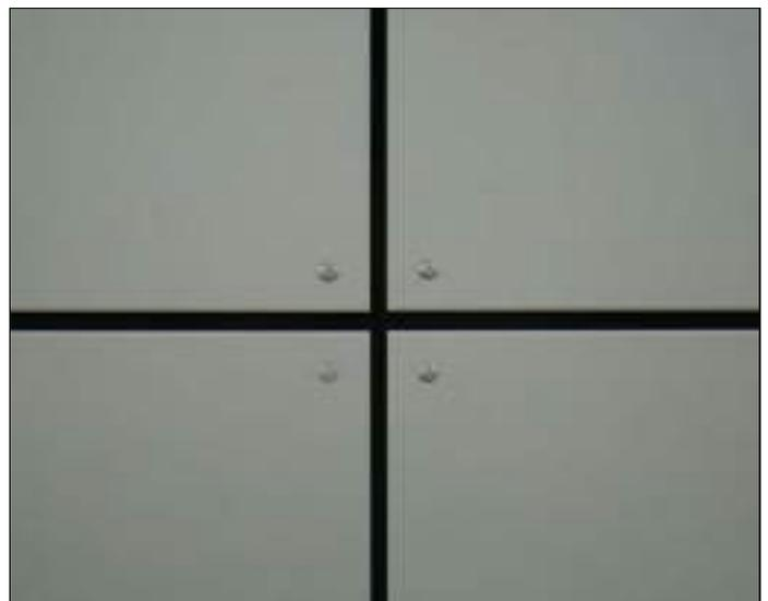
Richten Sie die Platten sorgfältig nach dem rechten Winkel aus um eine schönes gleichmäßiges Fugenbild an der Gebäudehülle zu bekommen. Befestigen Sie nun die Schwelle der Frontseite des Gebäudes mit dem Fundament.
