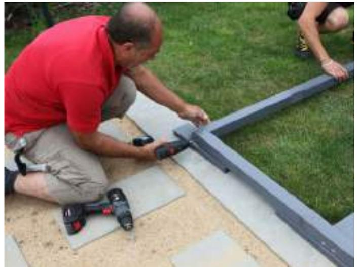
Schrauben Sie dann die beiden Eckpfosten im Türbereich an der vorgesehenen Aussparung ebenfalls mit 2x C105-0100 von unten durch die Schwellen an. Bitte beachten Sie dabei die Richtung der Pfosten bezüglich der Türbeschläge!
