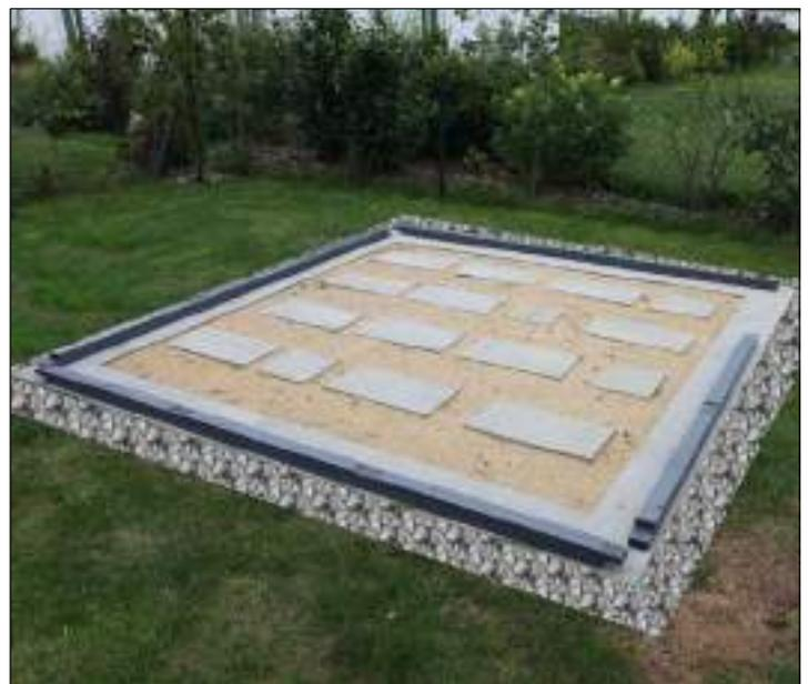
Als Auflagefläche für die Grundlager des optional zu erwerbenden Fußbodens können Sie z.B. Gehwegplatten verwenden. Um das Gebäude vor Spritzwasser zu schützen, schütten Sie einen ca. 30 cm breiten Kiesstreifen rings um das Fundament.
