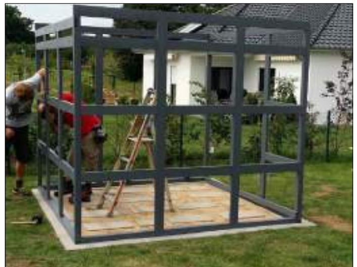
Die äußeren Riegel einer Seite verschrauben Sie an der Außenseite, ebenfalls nach dem Vorbohren, mit C105-0100, durch den Pfosten. Die inneren Schrauben setzen Sie schräg von unten durch den Riegel in die jeweiligen Mittelpfosten.
