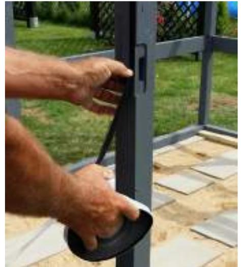
Bekleben Sie das Grundgerüst mit dem EPDM Dichtband A109 (9mm breit) und A111 (30mm breit). Verwenden Sie für die Bereiche in denen 2 Platten aneinander stoßen A111 und für die Ober- und Unterseite des Gerüstes A109. Das Dichtband muss ohne Abstand dicht auf Stoß geklebt werden um eindringendes Wasser zu verhindern. In den Eckbereichen kleben Sie das Dichtband zu gleichen Teilen um die Ecke. Halten Sie oben einen Abstand von 0,5cm bis zur Kante!
