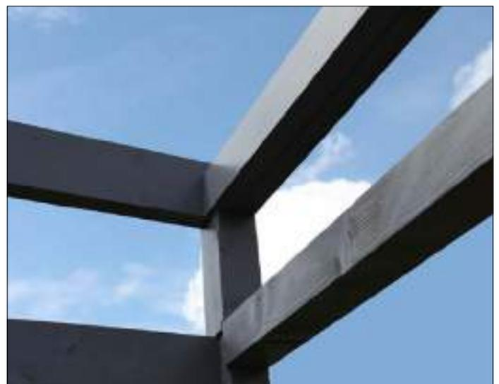
Positionieren sie nun Kantholz als Auflager für die Dachbretter auf den Eckpfosten an der Frontseite, bohren vor und verschrauben es mit 5x C105-0050 von innen an der Rähm. Halten Sie aussen einen Abstand von ca. 5cm ein.
