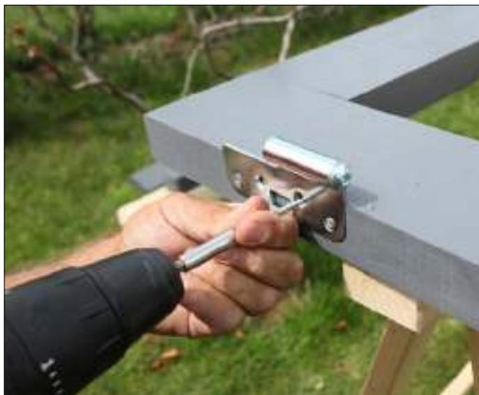
Legen Sie sich das Türblatt auf die richtige Seite und schrauben Sie nun die drei Beschläge des Türblattes nach dem Vorbohren mit je 4 der beiliegenden Schrauben an die dafür vorgesehenen Aussparungen.
