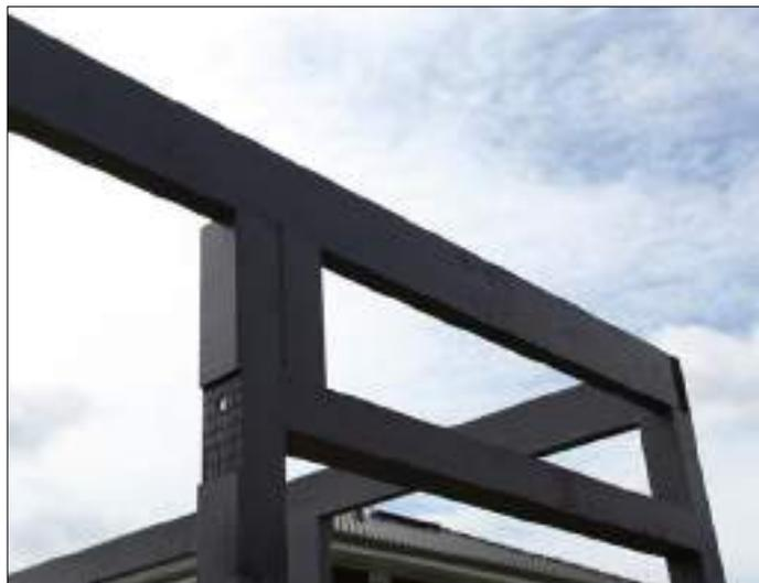
Legen Sie die das waagerechte Kantholz für den Türsturz in die dafür vorgesehenen Aussparungen und achten Sie darauf die Bauteile an den Außenkanten bündig zu setzen. Bohren Sie vor und verschrauben mit 2x C105-0100 jeweils von aussen durch die Pfosten. Halten Sie beim Schrauben ca.4cm Abstand von der Außenkante.
