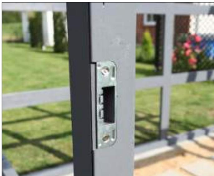
Positionieren Sie dann den Beschlag für das Schloß in der Aussparung am linken Türpfosten und verschrauben sie diesen nach dem Vorbohren mit 2 der dem Schloß beiliegenden Schrauben.
