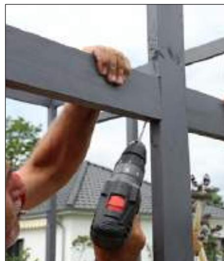
Nun platzieren Sie den ersten Riegel an der dafür ausgesparten Stelle und verschrauben diesen nach dem Vorbohren mit je 1x C105-0150 einmal gerade durch den Pfosten in den Riegel und einmal schräg von unten durch den Riegel mit 1x C105-0100 in den Pfosten. Schrauben Sie mit einem Abstand von 4cm schräg in den Pfosten.
