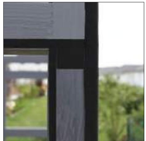
Kleben Sie das Dichtband genau auf Stoß um das Eindringen von Feuchtigkeit zu verhindern! Lassen Sie die senkrechten Dichtbandstreifen durchgehen und kleben Sie im Anschluss die waagerechten Streifen passgenau dazwischen. Halten Sie oben einen Abstand von 0,5cm bis zur Kante!
